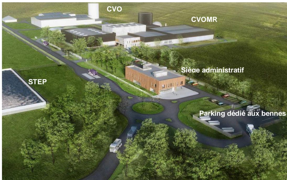
La plupart des installations seront abritées au sein de cinq bâtiments principaux, dont les hauteurs varieront entre 10 m et 16 m. Les équipements non situés dans un bâtiment qui, par leurs dimensions, auront l'impact visuel le plus fort vis-à-vis de l'extérieur, seront, le digesteur de la méthanisation et le gazomètre implantés en partie nord-ouest du site, d'une hauteur respectivement de 23 m et 10,3 m.
